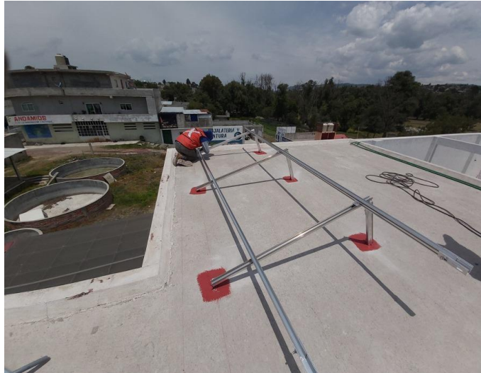
Figura 13. Imagen de ejemplo de fijación y sellado en cada perforación.
